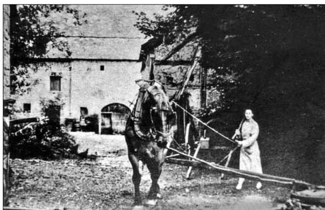
Logne-Vieuxville (1940) - Francine Ancia fait avancer le cheval qui actionne un manège qui, lui, fait fonctionner une batteuse.
